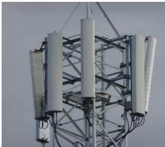
**Figura 19.- Instalación ant. sectoriales**
